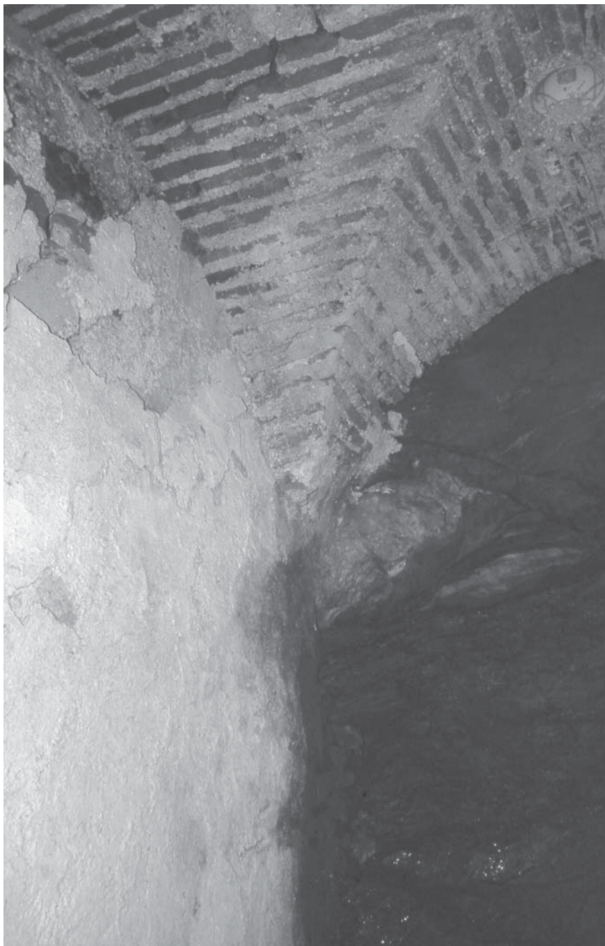
Lam. 2. Arranque de la bóveda y roca madre en el interior del aljibe.
