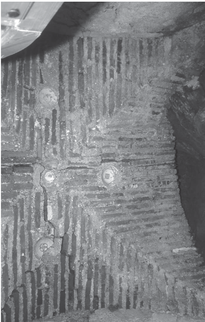
Lam. 3. Bóveda del interior del aljibe.
